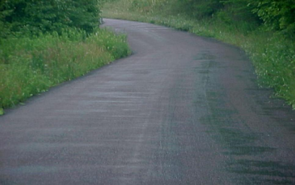
Asfalto sobre base estabilizada com TerraZyme®
